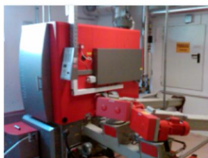
Fotos Oben: Haupt- u. Musikschule mit Mehrzweckhalle Unten: Hackguteinbringung und 200 kW Kesselanlage
